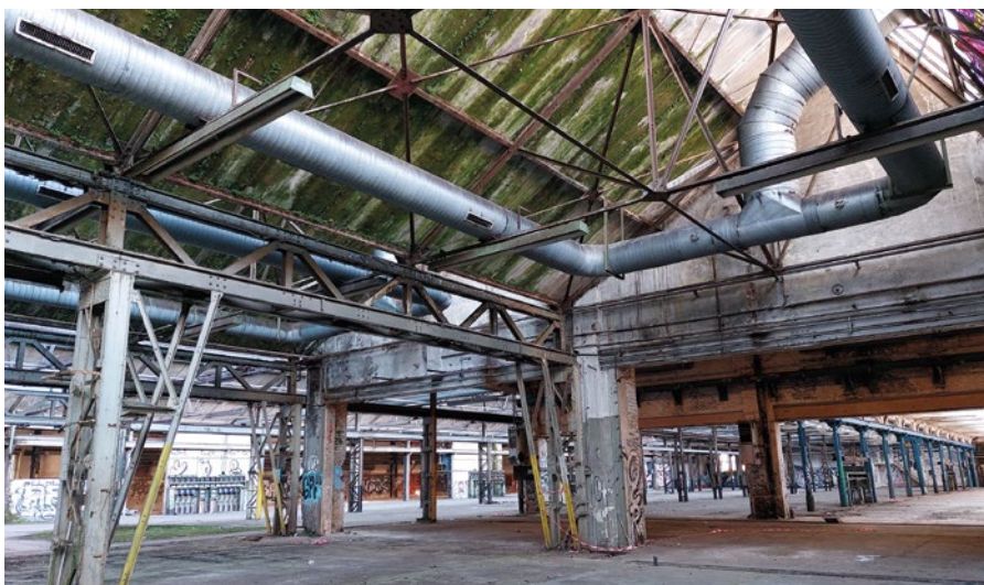
Industriehalle KHD - Kleinmotorenbau
